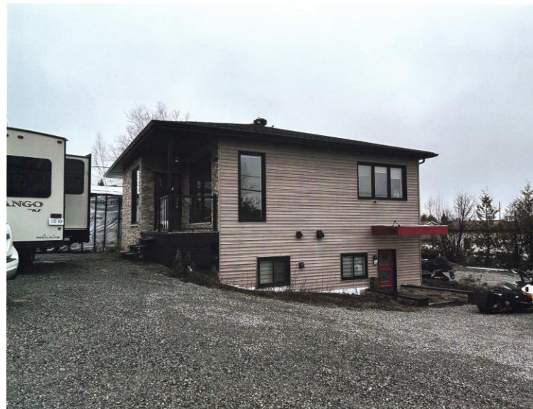
Travaux de rénovation en cours
