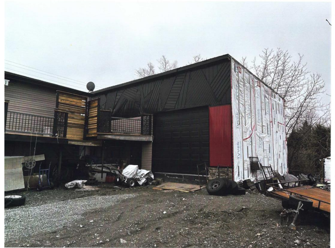
Garage annexé à convertir
