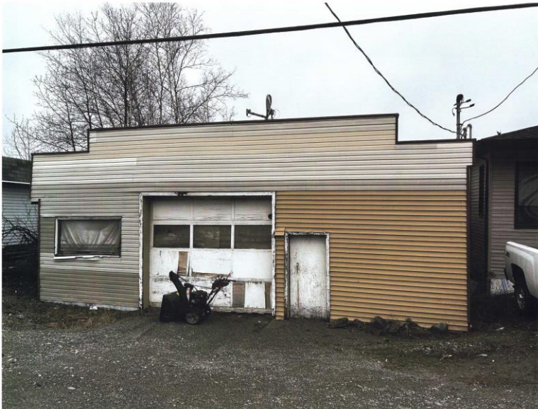
Garage à démolir
