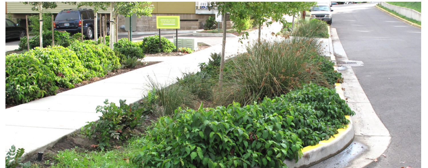
Gestion des eaux de pluie intégrée aux aménagements, Portland, Oregon
